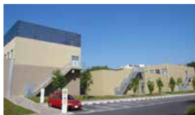
TMC 棟・ クラスター研究棟
