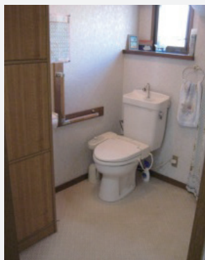
扉は折り戸、広いスペース、 し字手すり
