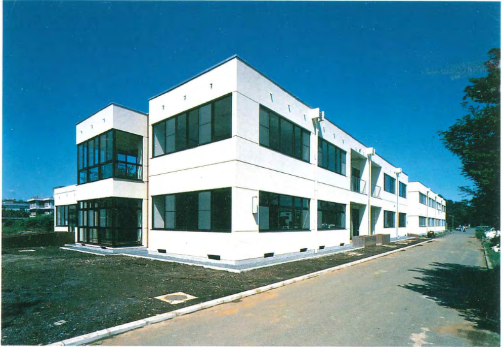
完成した機能訓練棟
